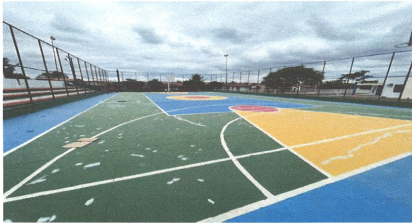
RECUPERAÇÃO DO PISO DA QUADRA POLIESPORTIVA
