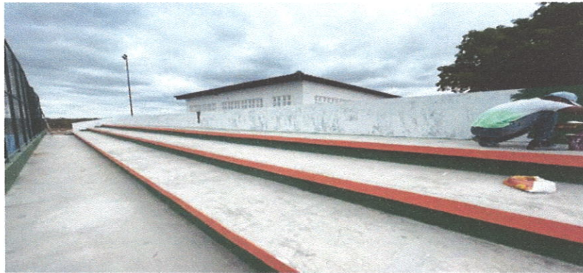
PINTURA DE ARQUIBANCADA
